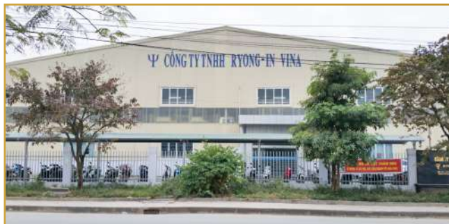
DỰ ÁN: THI CÔNG SƠN NỀN VÀ CHỐNG THẤM CÔNG TY TNHH RYONG-IN VINA CĐT: Công ty TNHH RYONG-IN VINA Địa chỉ: KCN Quế Võ, Nam Sơn Bắc Ninh
