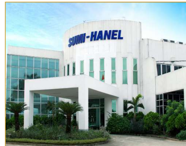
DỰ ÁN: THI CÔNG SƠN NỀN, TƯỜNG THUỘC DỰ ÁN MỞ RỘNG XƯỞNG SẢN XUẤT DÂY DẪN NHÀ MÁY SUMI HANEL CĐT: Công ty TNHH Hệ thống dây Sumi - Hanel Địa chỉ: KCN Sumi - Hanel, Sài Đồng - Gia Lâm - Hà Nội
