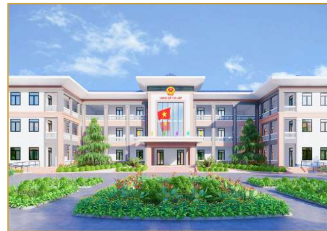
DỰ ÁN: THI CÔNG SƠN TRẦN TƯỜNG, CỘT VÀ CÁC CÔNG TRÌNH PHỤ TRỢ THUỘC DỰ ÁN XÂY DỰNG UBND XÃ TỰ LẬP CĐT: UBND Xã Tự Lập Địa chỉ: Xã Tự Lập, Mê Linh, Hà Nội
