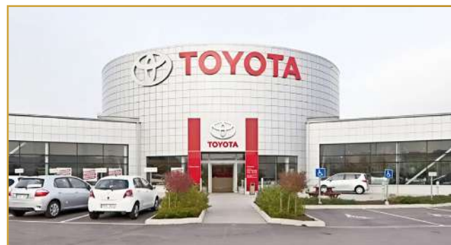
DỰ ÁN: THI CÔNG SƠN NỀN KHO CHỨA ĐỒ CPD THUỘC DỰ ÁN MỞ RỘNG NHÀ KHO CÔNG TY TOYOTA VIỆT NAM CĐT: Công ty Ô tô TOYOTA Việt Nam Địa chỉ: Phúc Yên, Vĩnh Phúc
