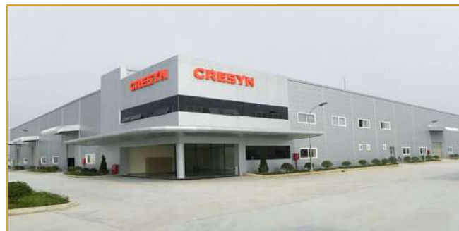
DỰ ÁN: THI CÔNG SƠN NỀN NHÀ MÁY CÔNG TY TNHH CRESYN HÀ NỘI CĐT: Công ty TNHH Cresyn Hà Nội Địa chỉ: Cụm công nghiệp Đông Thọ, Yên Phong, Bắc Ninh
