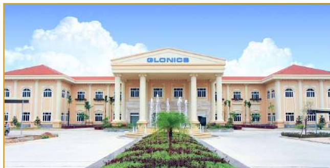
DỰ ÁN: THI CÔNG SƠN NỀN EPOXY, CHỐNG THẤM NỀN DỰ ÁN CẢI TẠO NHÀ MÁY CÔNG TY TNHH GLONICS VIỆT NAM CĐT: Công ty TNHH GLONICS VIỆT NAM Địa chỉ: Phường Tích Lương, TP. Thái Nguyên, Thái Nguyên
