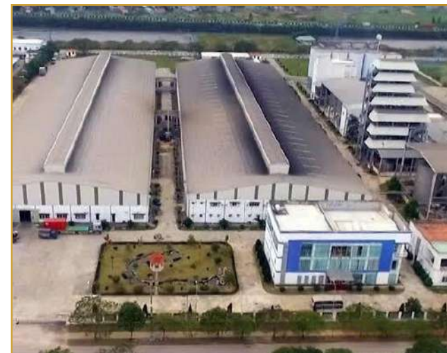
DỰ ÁN: CẢI TẠO SỬA CHỮA SƠN NỀN EPOXY, SƠN TƯỜNG NHÀ MÁY RƯỢU HÀ NỘI CĐT: Công ty Cổ phần Cồn rượu Hà Nội Địa chỉ: KCN Yên Phong Bắc Ninh
