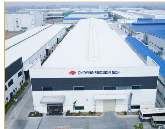
DỰ ÁN: THI CÔNG SƠN NỀN NHÀ MÁY CHITWING COMPANY VIỆT NAM CĐT: Công ty CHITWING COMPANY Việt Nam Địa chỉ: KCN Tiên Sơn, Bắc Ninh
