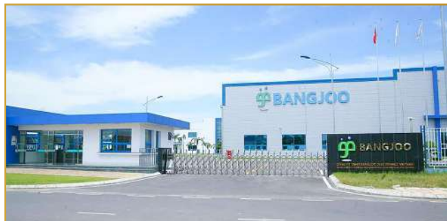
DỰ ÁN: THI CÔNG MÀI NỀN VÀ XỬ LÝ BỀ MẶT NỀN NHÀ MÁY BANGJOO CĐT: Công ty TNHH Xây dựng MIRAE Địa chỉ: Khu công nghiệp Bá thiện 1, Bình Xuyên, Vĩnh Phúc
