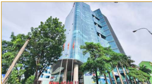
DỰ ÁN: THI CÔNG SƠN NỀN EPOXY TẦNG HẦM TÒA NHÀ VĂN PHÒNG TỔNG CÔNG TY 789 BỘ QUỐC PHÒNG CĐT: Công ty Cổ phần Đầu tư Thái Sơn Địa chỉ: Đường Hoàng Quốc Việt - Hà Nội
